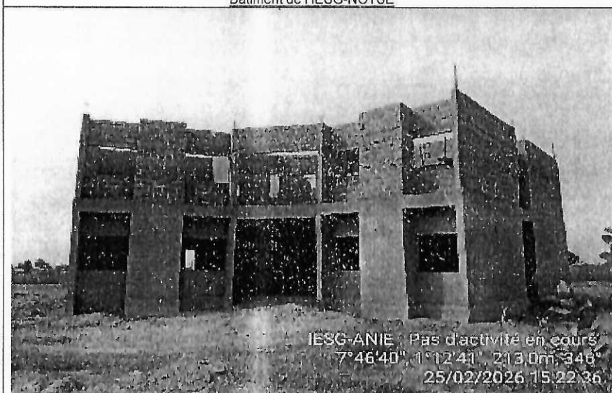
Bâtiment de l'IESG-ANIE
