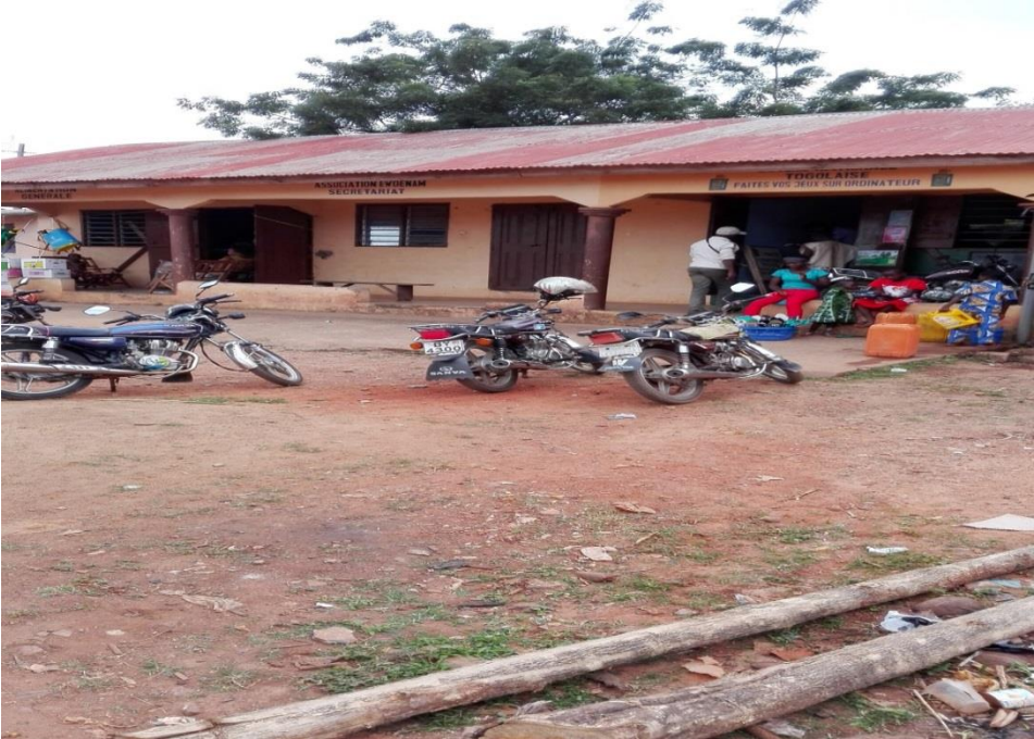
Trois boutiques construites au lieu d'un fougou bar et une boutique
